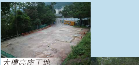
大樓高座工地
