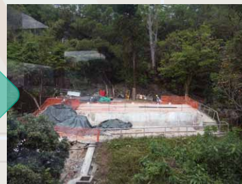
拆卸後平整好的工地
