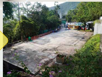
拆卸後平整好的工地
